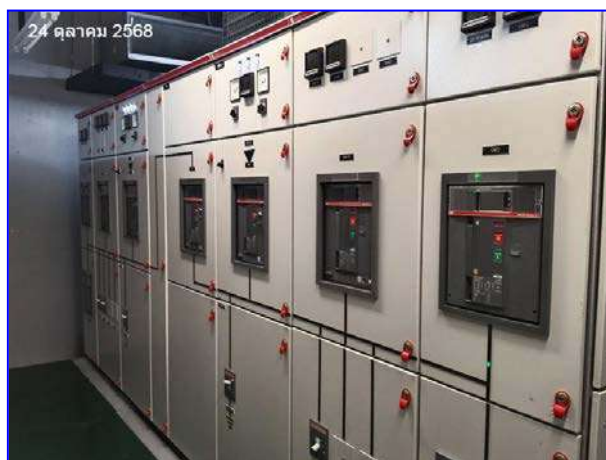
รูปที่ 2.14 ตู้ MDB (Main Distribution Board)
